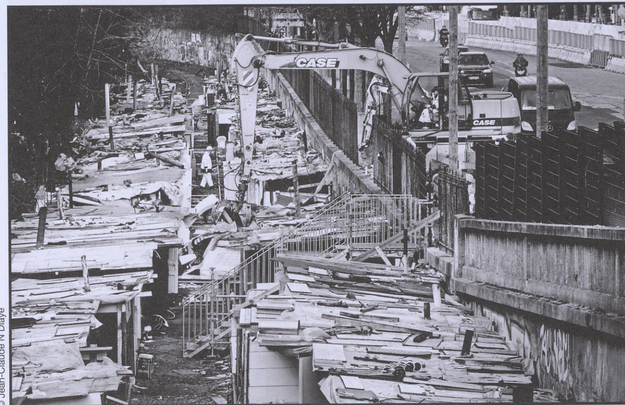
Sitôt les habitants expulsés, le bidonville a été démolì à grands coups de pelleteuses.
