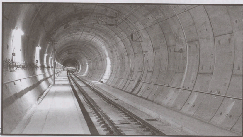
Les travaux dans le tunnel de la ligne 14 dureront jusqu'en 2019 !
