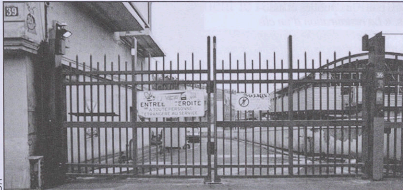
Des grilles devant l'accès prévu de la salle de consommation.
