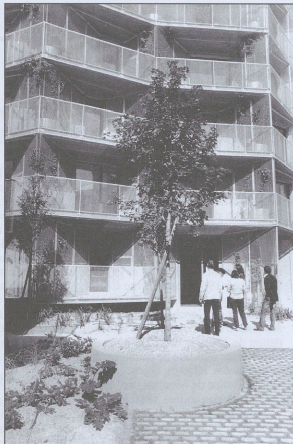
La façade sur cour de l'immeuble tout neuf du 18 rue René-Caillié. La cour est partagée avec le nouvel immeuble du 13 rue d'Aubervilliers.
