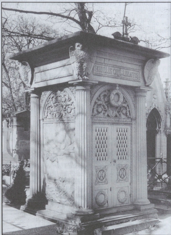
Le tombeau de Cavé au cimetière Montmartre, avenue de Montmorency. Entièrement en fonte, il porte des bas-reliefs (en fonte eux aussi) évoquant la carrière du défunt. Un des bas-reliefs représente la mort faisant sombrer le navire de Cavé.
