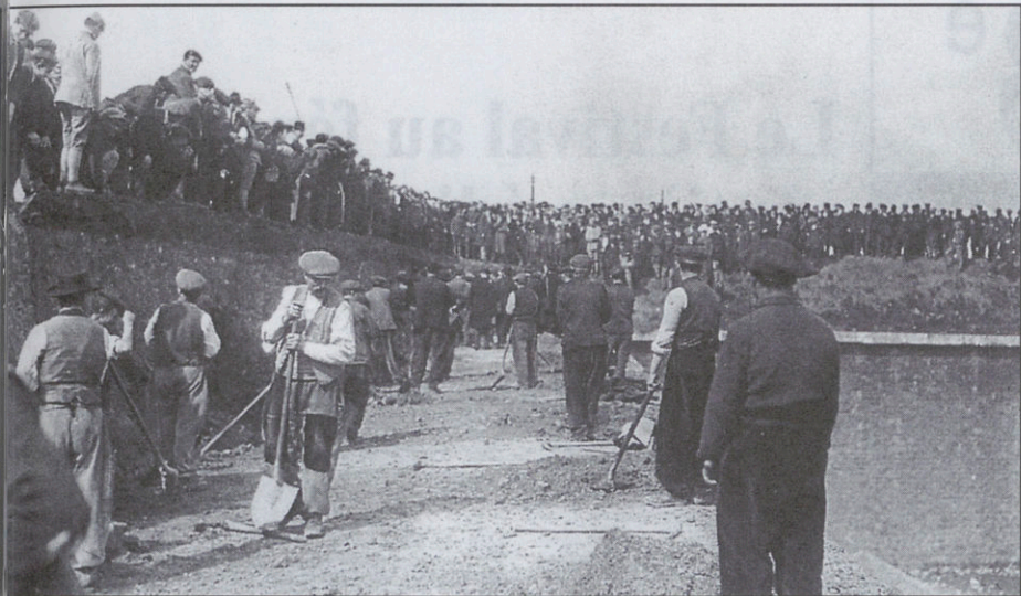
Juillet 1919, Porte de Clignancourt : premiers coups de pioche de la démolition des fortifs.
