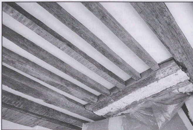
Poutres apparentes d'un appartement du deuxième étage.
