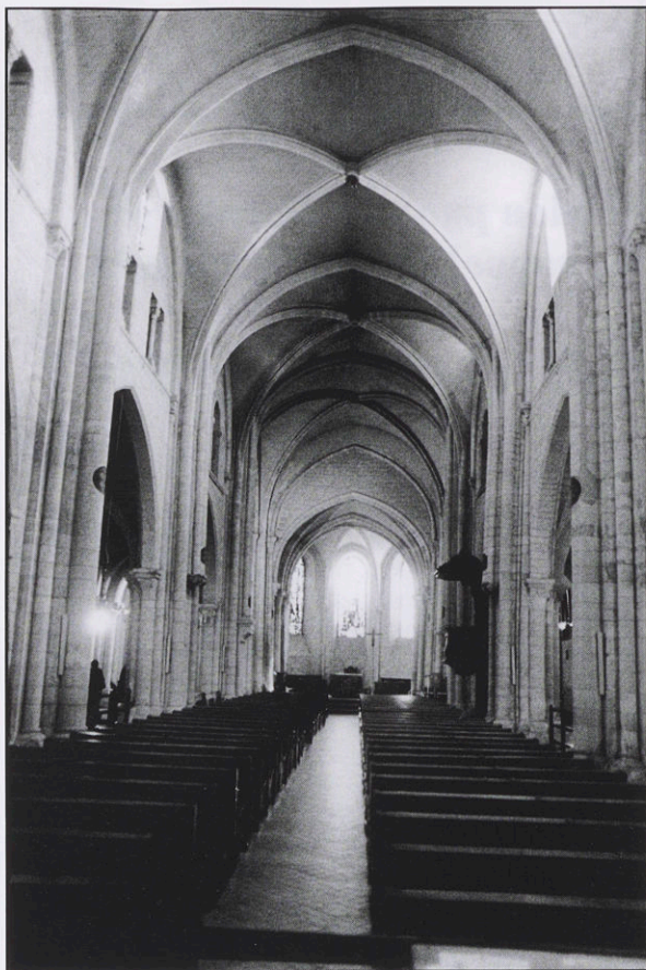
Vue de la nef. La voûte en croisées d'ogives a remplacé au XVe siècle le plafond en bois d'origine.
