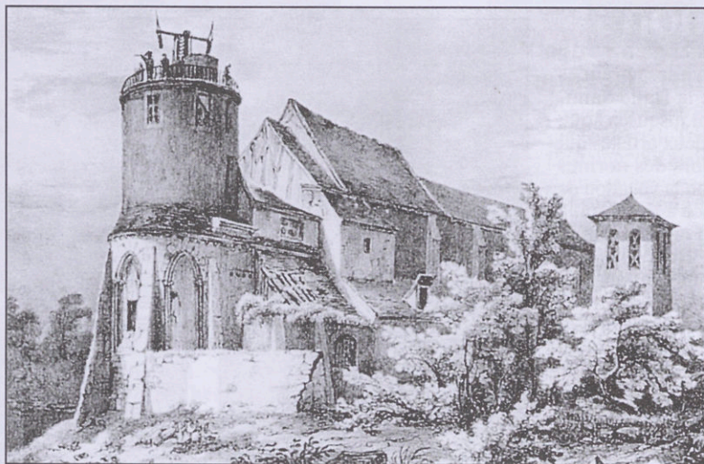
La "Tour du télégraphe", installée au-dessus de l'église, y est restée jusqu'en 1866 et a contribué à l'affaissement des murs. (Ici, une lithographie de C. Motte en 1824.)
