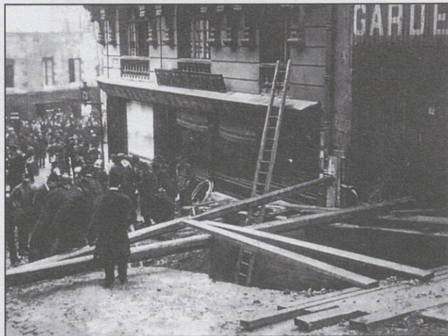
En 1909, soudain le sol sous la rue Tourlaque s'effondre, engloutissant deux passants.
