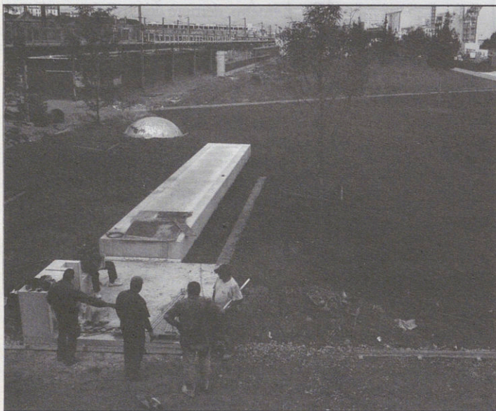
Les travaux d'aménagement prévoient, à l'extérieur du mur qui entourera le jardin, le long de la rue d'Aubervilliers, une large esplanade plantée d'arbres.
