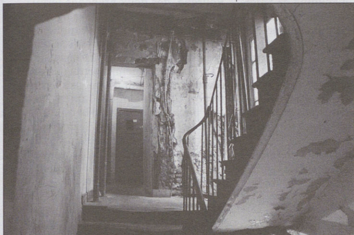
Dans l'immeuble du 25, rue Stephenson
