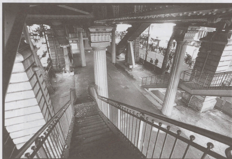
Une vue de la station Barbès-Rochechouart pendant les travaux
