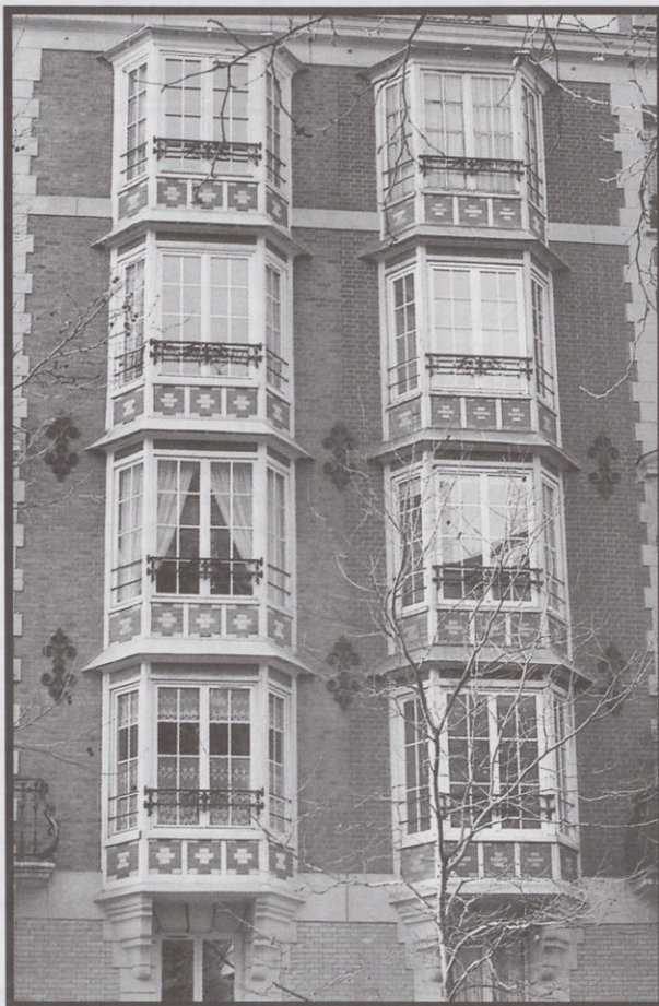
Au 71 et au 71 bis boulevard Ornano, deux beaux immeubles construits par l'architecte Charles Blanche en 1895, avec des bow-windows (fenêtres débordant de la façade) très caractéristiques.
