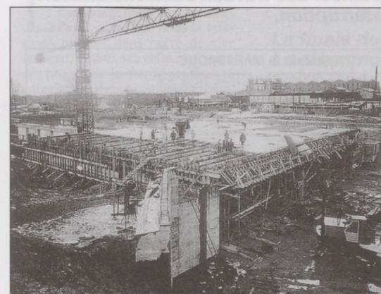
À gauche et à droite : Travaux de ferrailage et de bétonnage à la Porte d'Aubervilliers en 1966.
