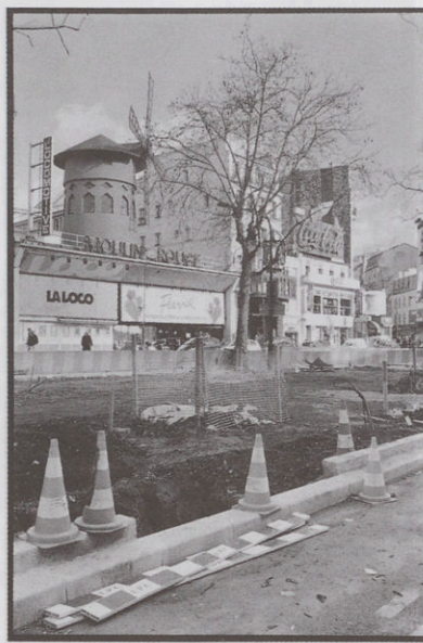
Les travaux de la première tranche, entre la rue Caulaincourt et la place Blanche, vont bon train.
