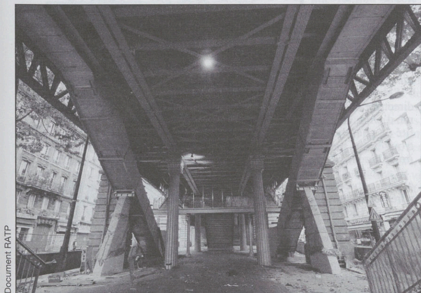
Vue du chantier, boulevard de la Chapelle, à l'arrière de l'entrée actuelle. A droite et à gauche, les escaliers mécaniques dans leur écrin de bois.
