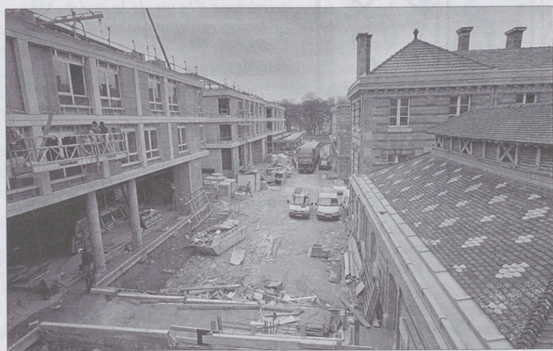
A gauche, les nouveaux pavillons de l'hôpital, en construction. A droite, deux des anciens pavillons, dont les murs extérieurs sont conservés.
