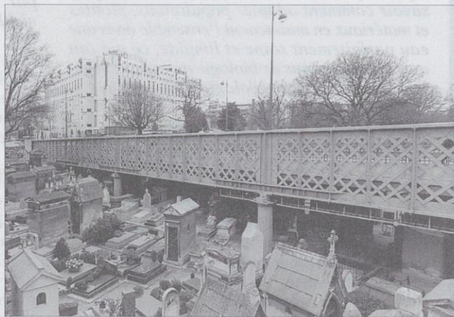
Le pont Caulaincourt, qui enjambe le cimetière Montmartre, est le premier pont de Paris construit en acier. Il repose sur six couples de colonnes de fonte et deux culées en maçonnerie à chacune des extrémités.
