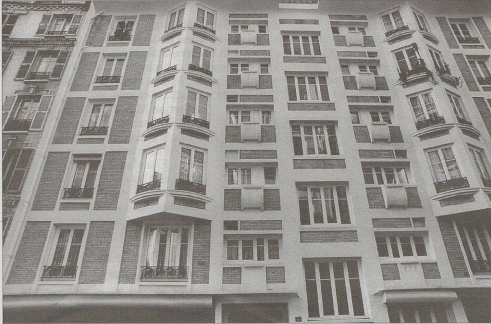
L'immeuble 7 rue de Trétaigne offre une façade superbement rythmée (que le manque de recul ne permet pas d'apprécier au mieux), et de belles portes "modern style".
