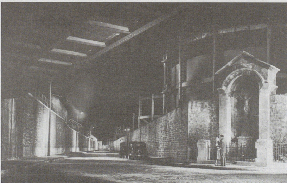
Une des scènes importantes du film est située à l'extrémité de la rue de l'Evangile, devant le grand crucifix (qui existe toujours) et les réservoirs de gaz (disparus aujourd'hui, et qui se trouvaient sur l'emplacement actuel de la zone d'entreprises «Cap 18»).
