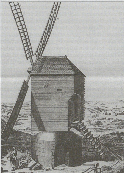
Moulin à vent au XVIII e siècle (planche de l' Encyclopédie de d'Alembert). Remarquer, en bas à droite, la «béquille» qui permet de faire pivoter le moulin pour prendre le vent.
